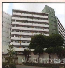
施工例（公共工事）
