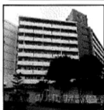
施工例（公共工事）
