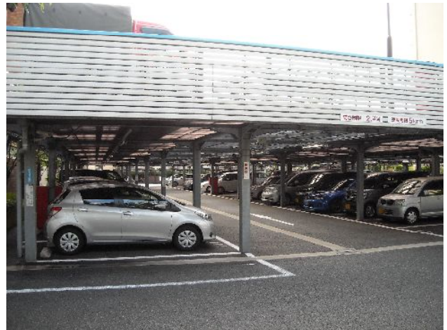
大型駐車場を設置するマンションも（大阪市内）
